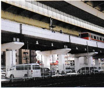
地下鉄中央線 橋脚部耐震補強工事
